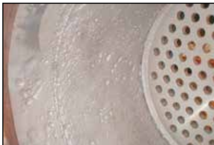
Después de la limpieza y la descontaminación, se aplica ARC 858 para llenar y alisar la superficie.
