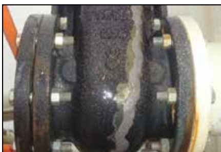
Se obstruyeron las fugas de la válvula con ARC 5ES.
