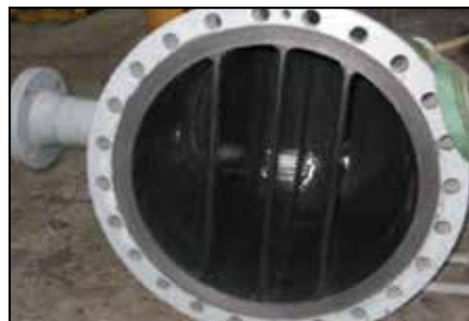
Platos divisores reparados.
