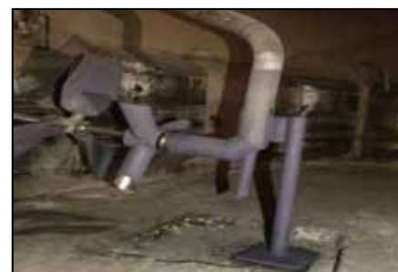
El diseño se modificó para incluir un apoyo adicional para el mezclador y la lanceta.
