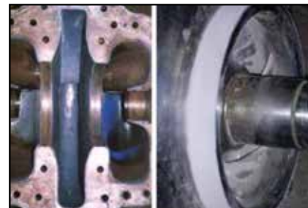
Recubrimiento de secciones de la bomba.
