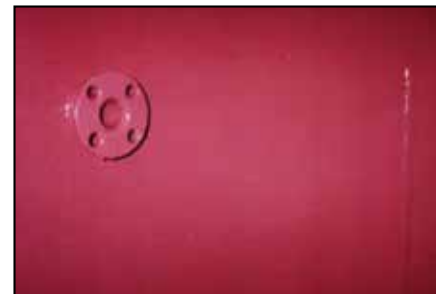
Después de una correcta preparación de la superficie, se aplicó ARC S4+ en un sistema de dos manos.
