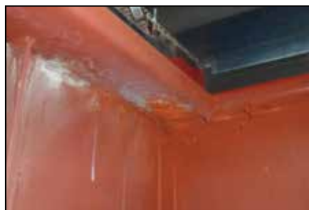
El recubrimiento original comenzó a fallar dentro de los 12 meses de su aplicación.
