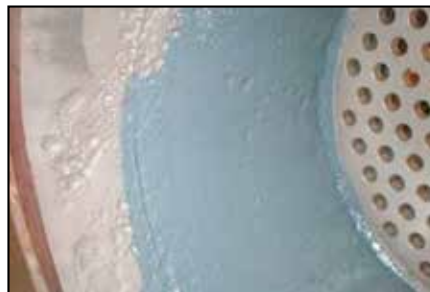
Después de la aplicación de ARC 858, se aplica ARC SD4i para protección y para lograr una mejora en la eficiencia de flujo.
