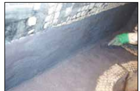
Superficies recubiertas con ARC I BX1.
