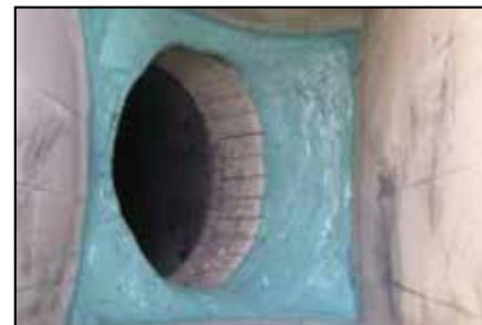
El ARC BX5 con la capa superior de ARC S2 se cura rápidamente, permitiendo un rápido retorno al servicio de la canaleta.
