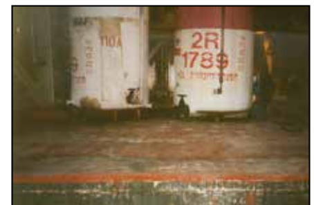
Áreas del piso recubiertas con ARC 988.
