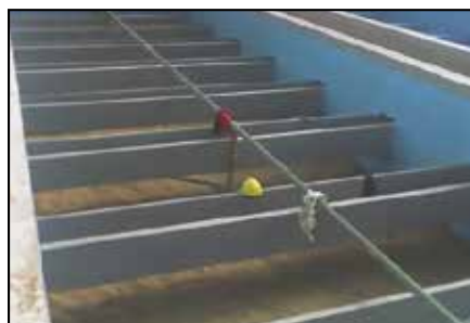
Instalación del recubrimiento ARC S1PW.
