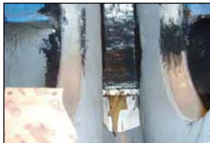
Bombas reconstruidas con ARC 858 y ARC MX2. Recubrimiento superior con ARC 855.
