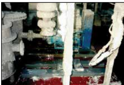
Base de la bomba recubierta con ARC 988: en buenas condiciones después de cuatro años
