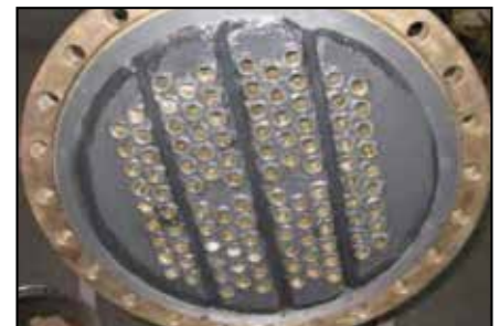
Placa de tubos completada.
