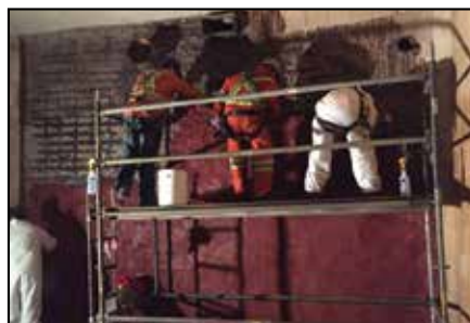
Instalación del recubrimiento ARC NVE.
