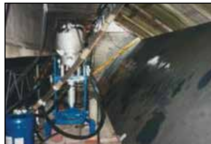
Se repararon las picaduras utilizando ARC 858.
