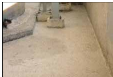
Se limpió y preparó la superficie.
