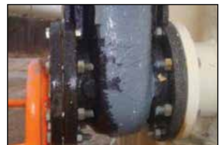
Se reparó la válvula con ARC 5.
