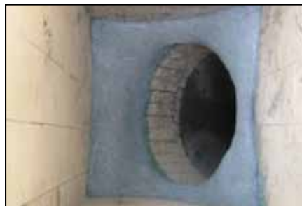
Instalación de ARC BX5.
