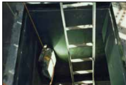
ARC especificado por el ingeniero de la planta.
