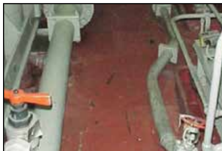
Recubrimiento anterior un año después de haber sido instalado.
