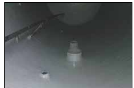
Componentes internos del tanque recubiertos.
