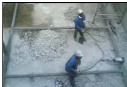
Preparación de la superficie.
