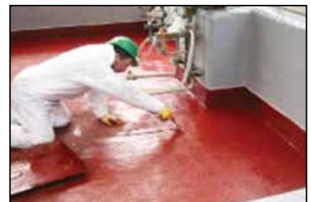
Aplicación de la capa superior ARC CS4.
