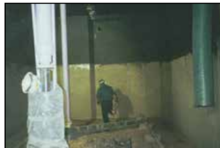
Concreto protegido con ARC 791 y ARC 988.
