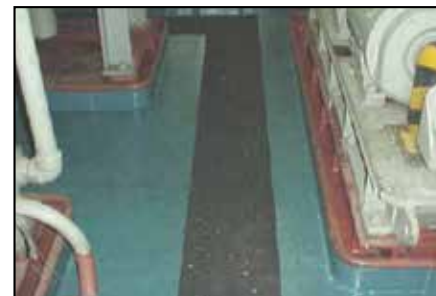
Regiones de circulación intensa recubiertas para evitar el resbalamiento.
