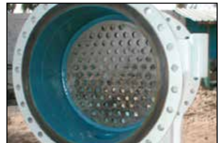
Después de la limpieza y la descontaminación, se aplica ARC 858 para llenar y alisar la superficie.
