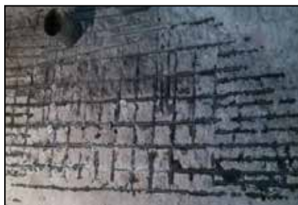
Pared del arcón después del desmontaje de la loseta y la limpieza con chorro abrasivo.
